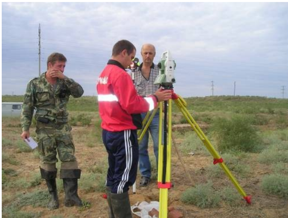
Рис.4. Опробование электронного прибора «Leica TPS-1202» в работе на объекте «Расчистка русел водных трактов в зоне западных подступных ильменей в Астраханской области»
