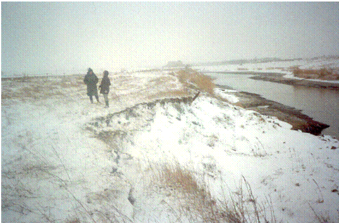
Рис. 2. Оползневые участки на магистральном канале
