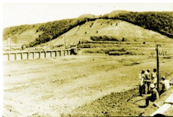
Рис. 1. Курганенская плотина на реке Куре, построенная на торфяном основании в 1929 г. (во время и после окончания строительства)
