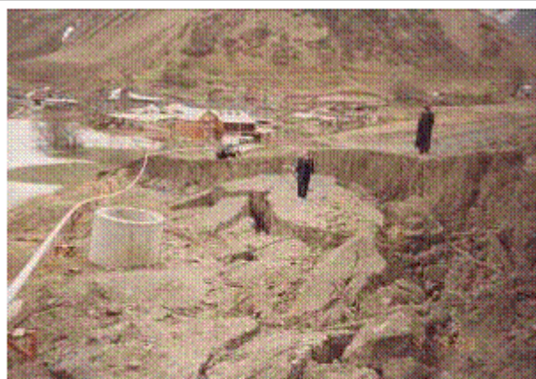
Рис. 9. 09 апреля 2004 г. Оползень на левом склоне р. Кауридон в с. Горная Саниба, вызванный замачиванием основания водами подпорного новообразования. Фото Э. Запорожченко
