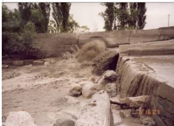
Рис. 17. 16 июня 2003 г. Сброс паводочного расхода ( \sim 30 \text{ м}^3/\text{с} ) через Гизельский гидроузел. Фото Э. Запорожченко
