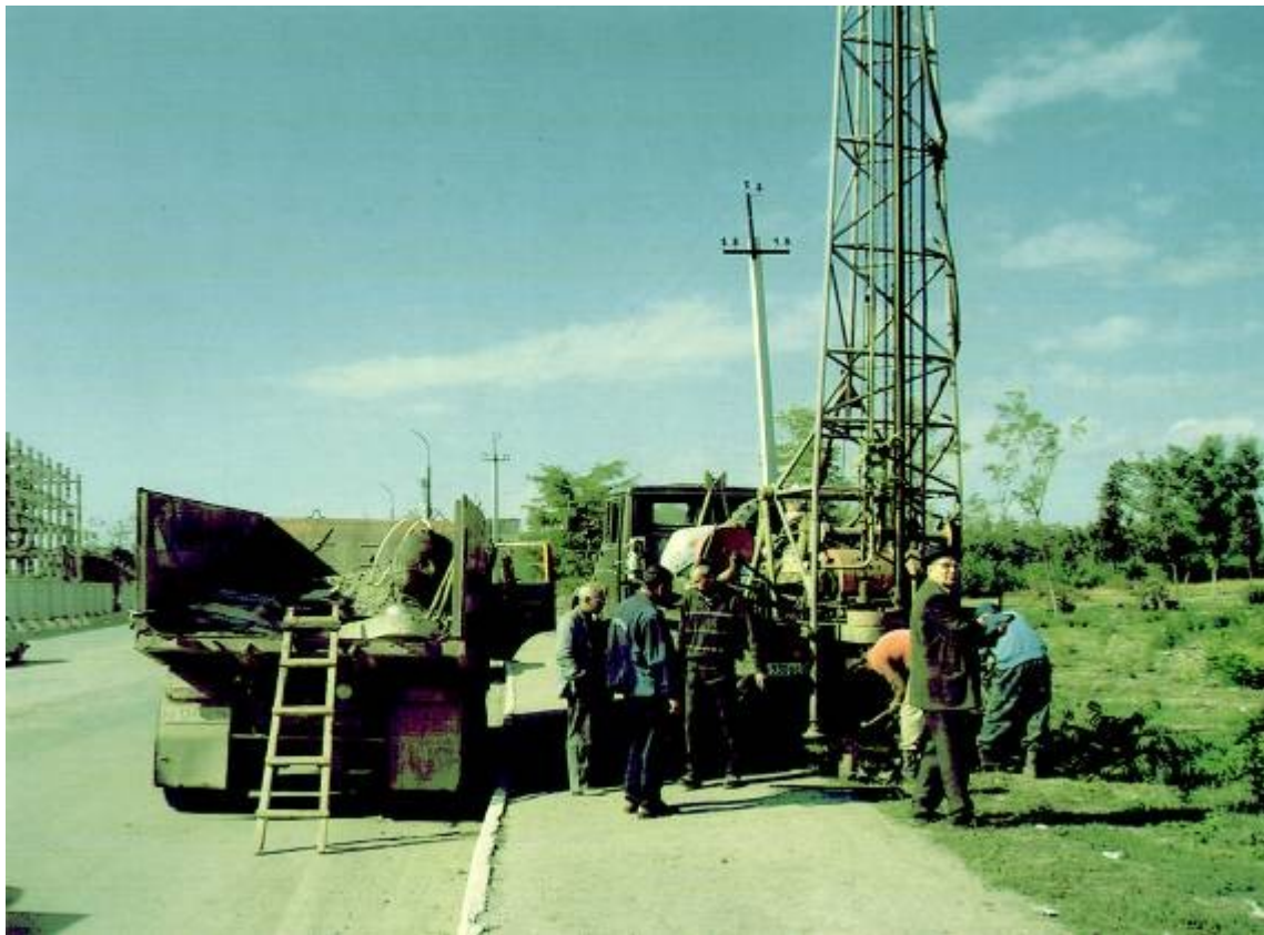
Устройство опорной геодезической сети в г. Грозном подразделением института «Севкавгипроводхоз», 2005 г.
