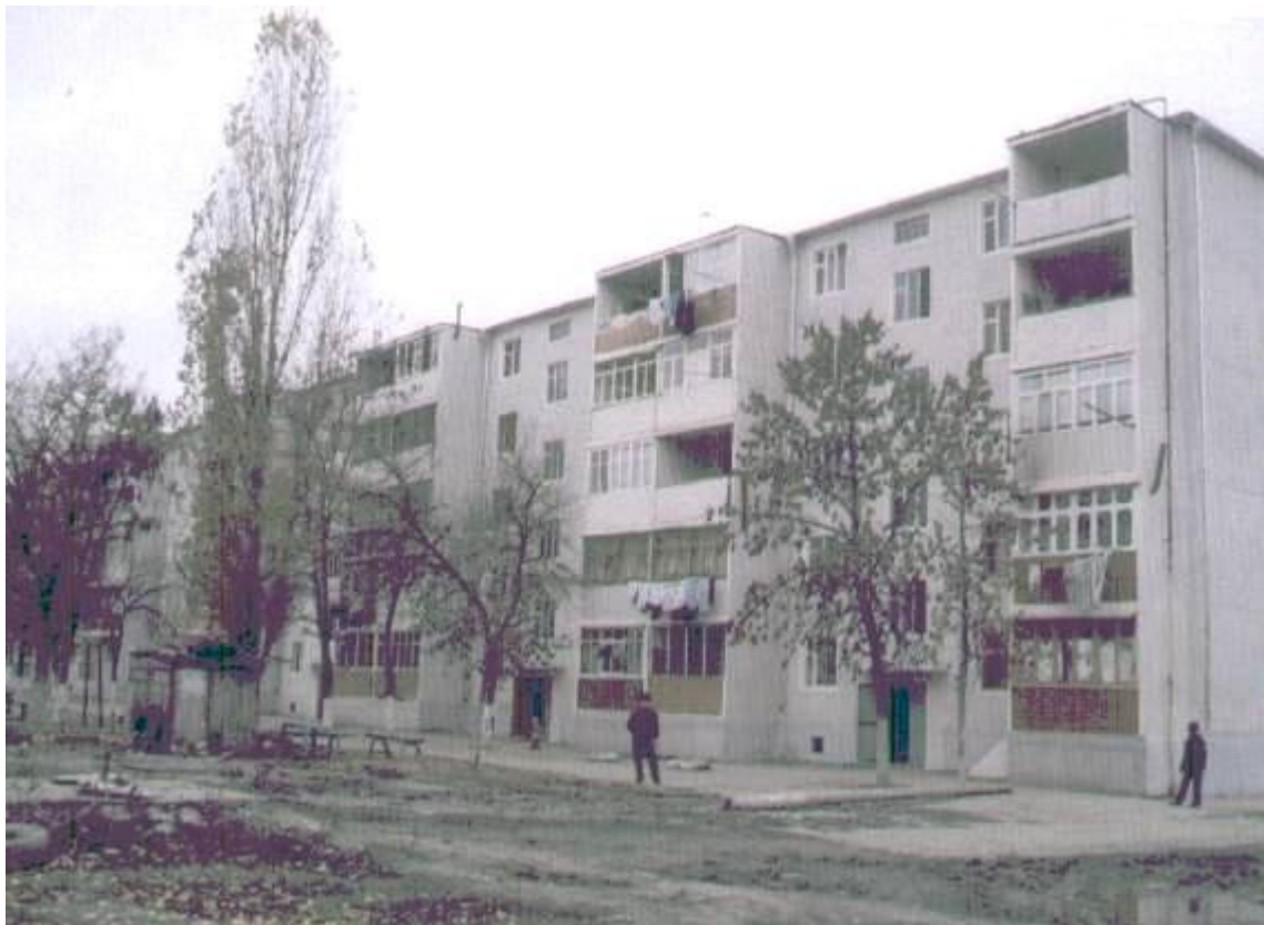
Рис. 10. Восстановленное по проекту института 30-квартирное жилое здание в г. Аргун
