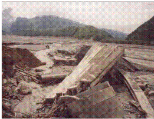
Рис. 14. 16 июня 2003 г. Прорывным паводком из подпрудного водоёма ( 20-25 \text{ м}^3/\text{с} ) разрушен, расположенный в 10 км ниже, автодорожный мост через р.Геналдон в её устье. Фото Э.Запороженко
