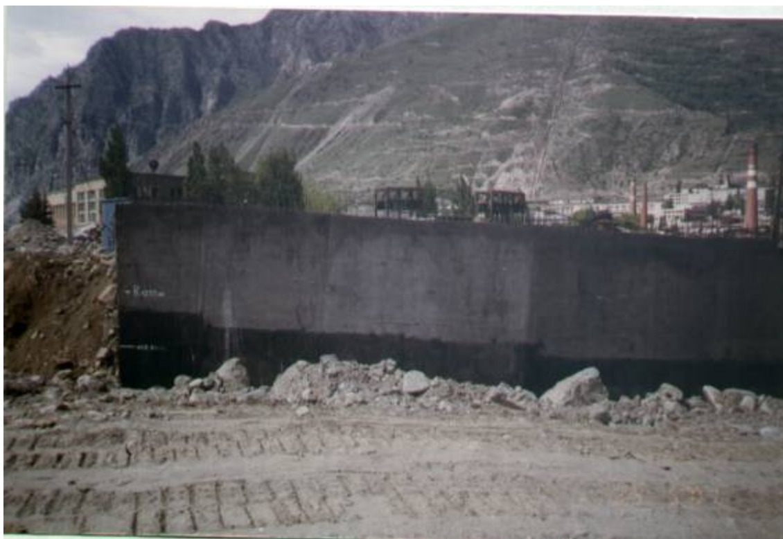
Рис.5. Возведение подпорной стенки селепропускного лотка в г. Тырныауз
