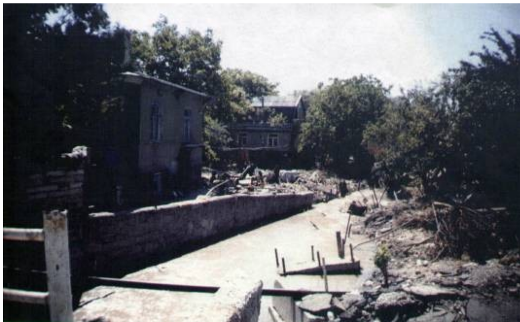
Рис.6. Затопление и разрушение жилых домов и коммуникаций в г.Ессентуки при прохождении катастрофических паводков по р. Бугунте в июне 2002 г.
