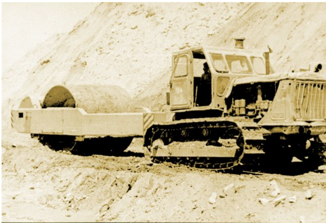
Рис. 12. Уплотнение катками насыпи из местных делювиальных глин на магистральном Большом Ставропольском канале.
