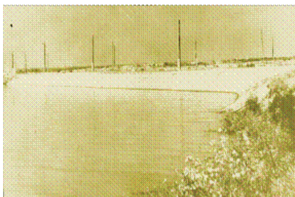
Рис. 1. Курганенская плотина на реке Куре, построенная на торфяном основании в 1929 г. (во время и после окончания строительства)
