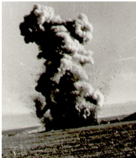
Рис. 15. Использование надземного взрыва для уплотнения основания насосной станции в зоне БСК
