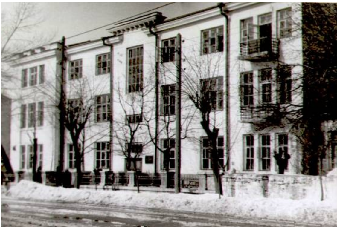
Рис. 1. Здание института в 50-е годы после его восстановления
