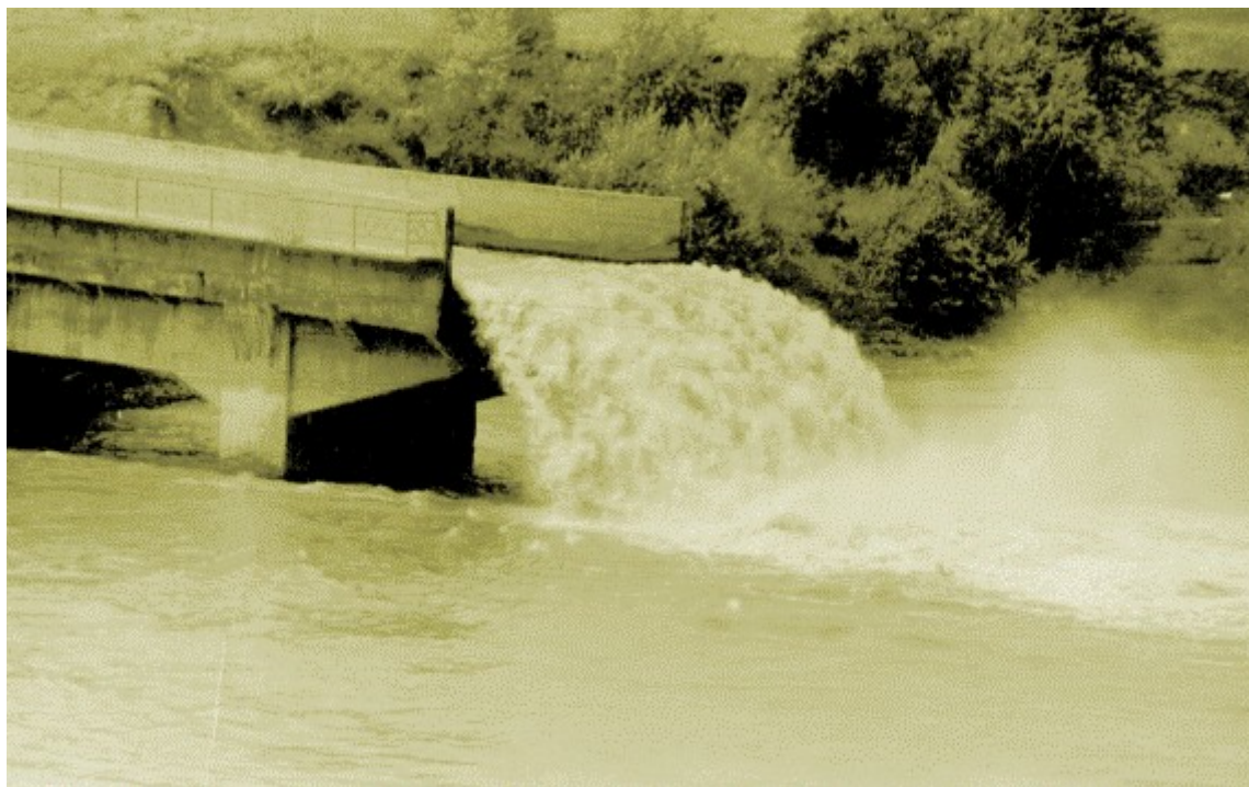
Рис. 6. Концевой консольный водосброс Невинномысского канала
