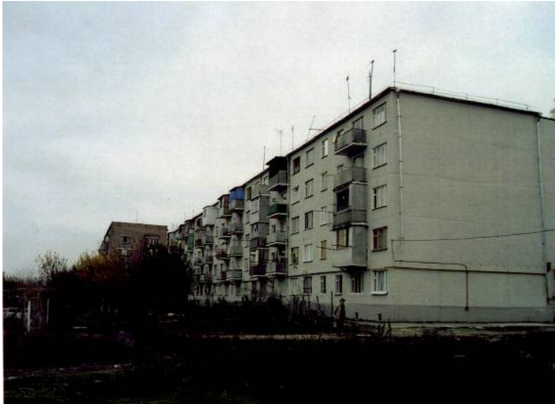
Жилой 80-квартирный дом в г. Аргун, 2005 г.
