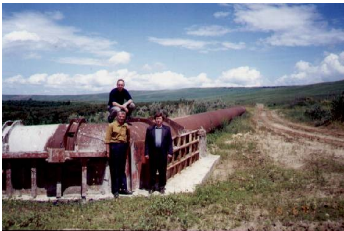
Рис.3. На объекте строительства новой системы водоснабжения г. Ставрополя из Сенгилеевского водохранилища
