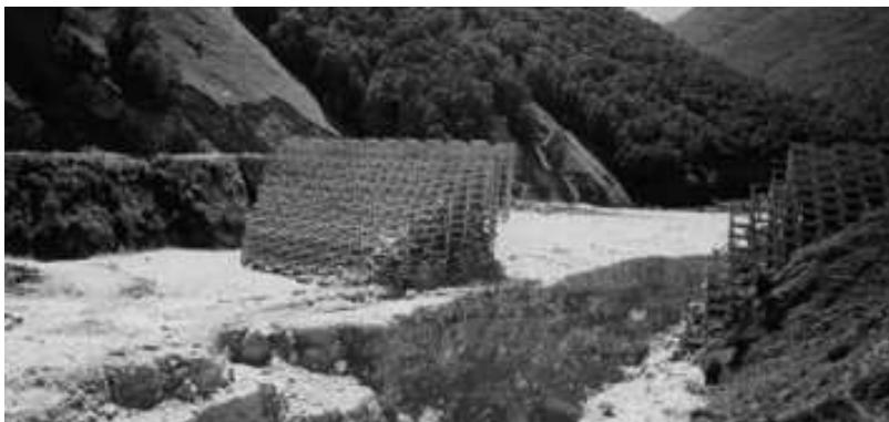
*Фото 3. На участке р. Герхожсан-Су выше селепропускного лотка была построена селеудерживающая плотина решетчатой конструкции (сдана в эксплуатацию в июне 1999 года).*
